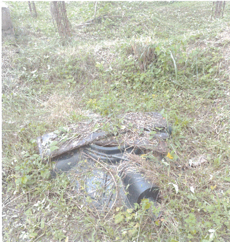
ภาพ ๖. ถังบำบัดน้ำเสียขนาด ๕,๐๐๐ ลิตร
